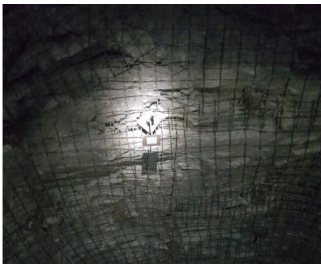
21-сурет – Жер асты тау-кен қазбаларында бақылау маркілерін бекіту
